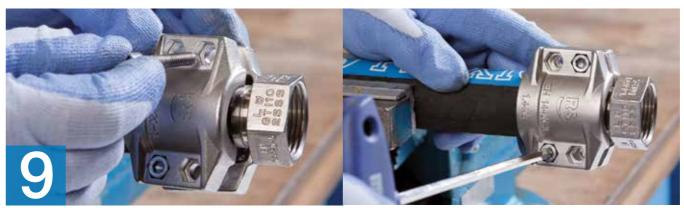
Alle Schrauben vor der Montage am Gewinde einfetten. Schalenhälften mit 2 längeren Montagehilfsschrauben gleichmäßig über Kreuz anziehen.
